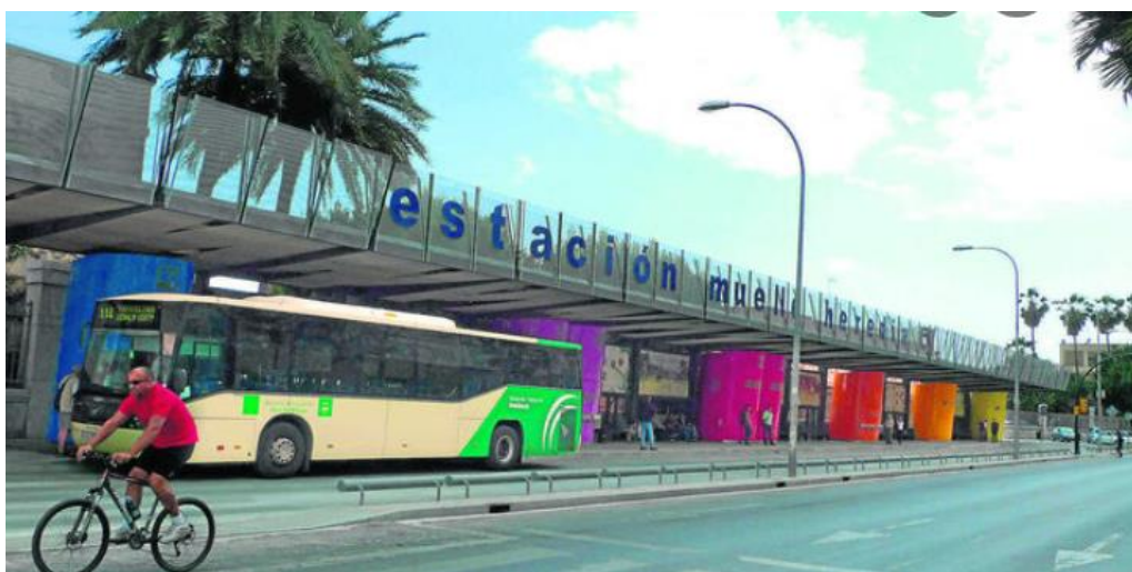
Ilustración 3. Frontal de la estación Muelle de Heredia.
