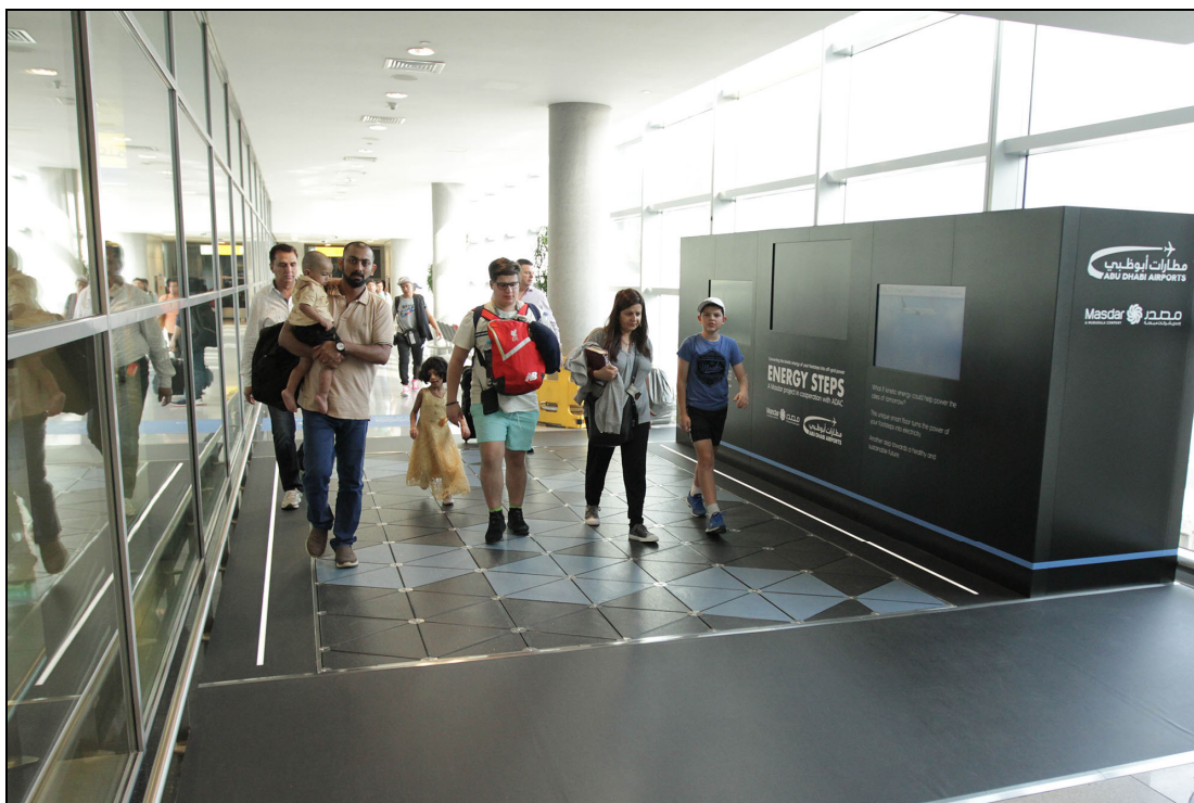
Figura nº5: Sistema Pavegen instalado en aeropuerto de Abu Dhabi (Fuente: www.pavegen.com )
