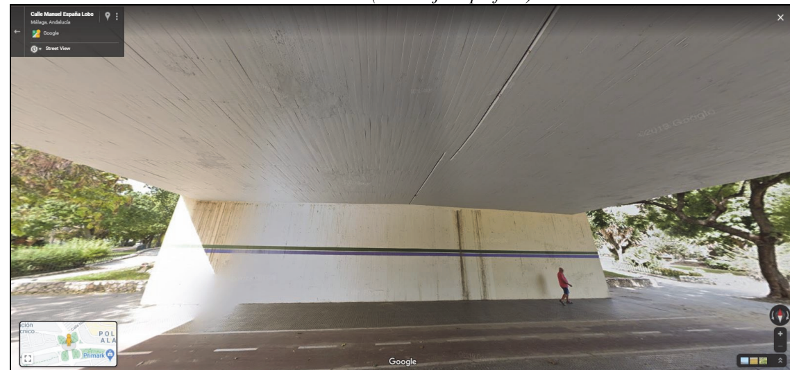
Ilustración 75: Tablero del Puente de las Américas (vista bajo superficie).
