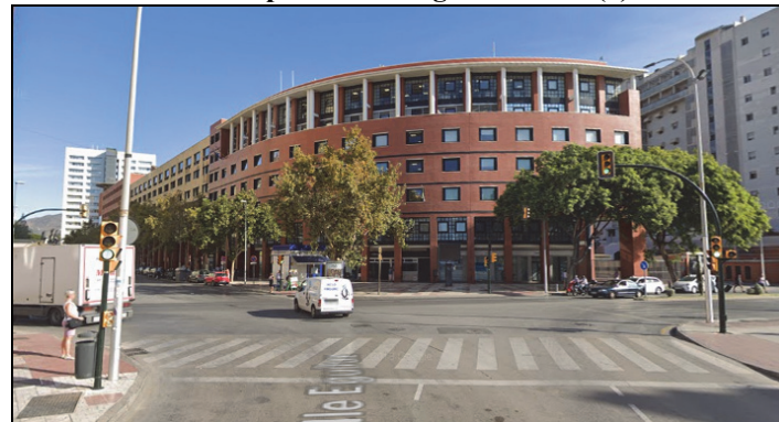
Paso de peatones C/Eguiluz Norte (4).
