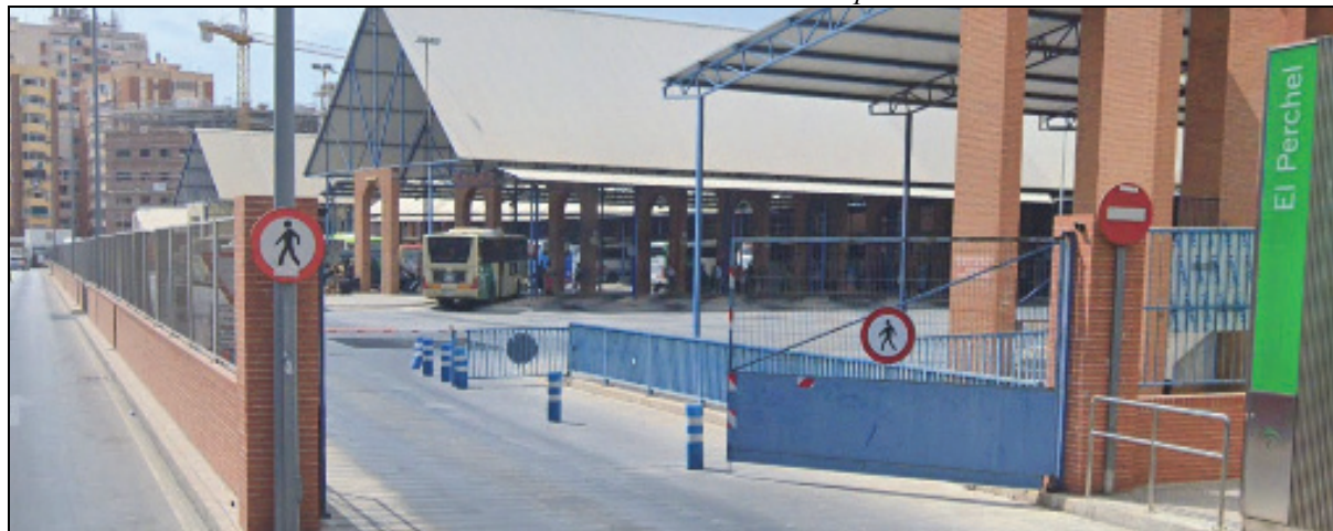
Ilustración 38: Zona de acceso a la estación de autobuses de Los Tilos por C/ Mendivil.
