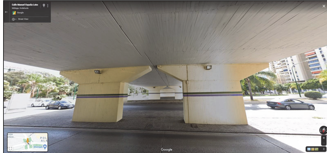
Ilustración 74: Tablero del Puente de las Américas (vista bajo superficie).
