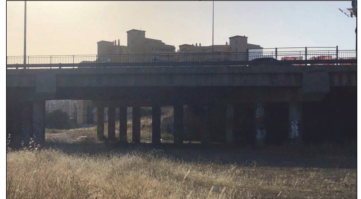
Ilustración 119: Entorno del Soterramiento del Ferrocarril bajo la MA-20.
