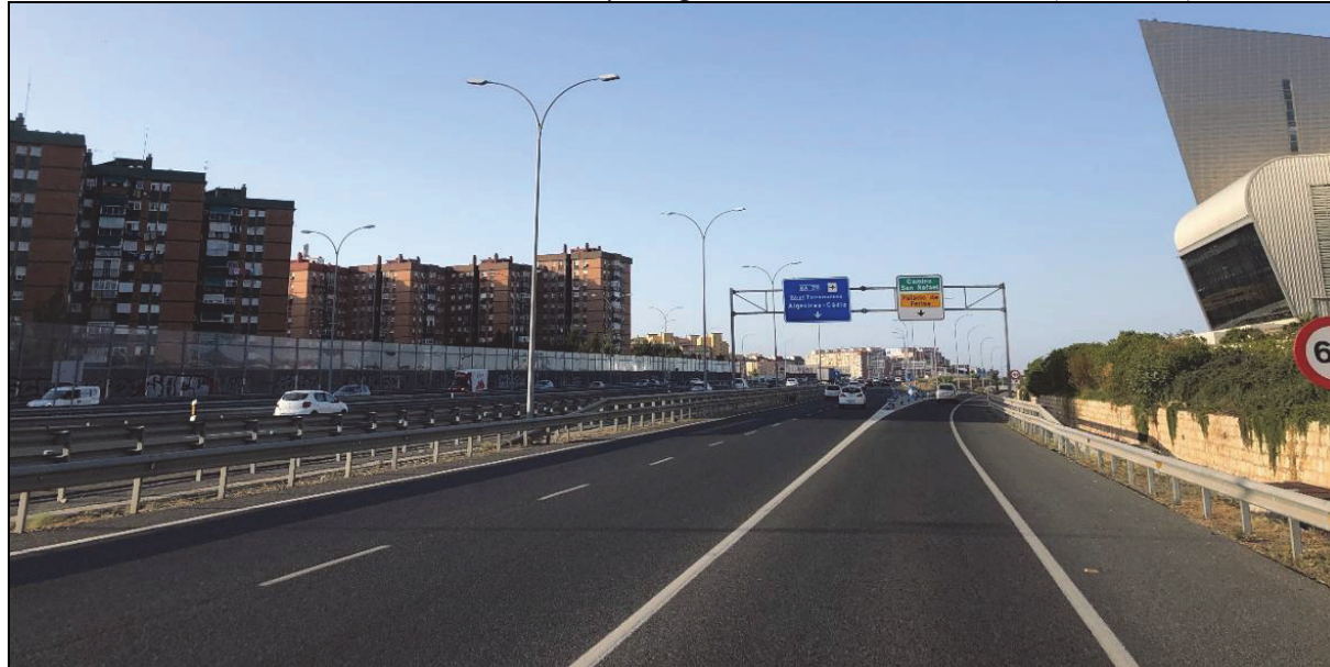
Ilustración 117: Salida hacia el Palacio de Ferias y Congresos desde la autovía MA-20 (sentido sur).
