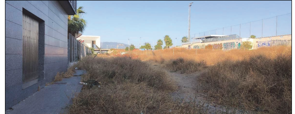
Ilustración 123: Soterramiento del Ferrocarril pendiente de urbanizar.
