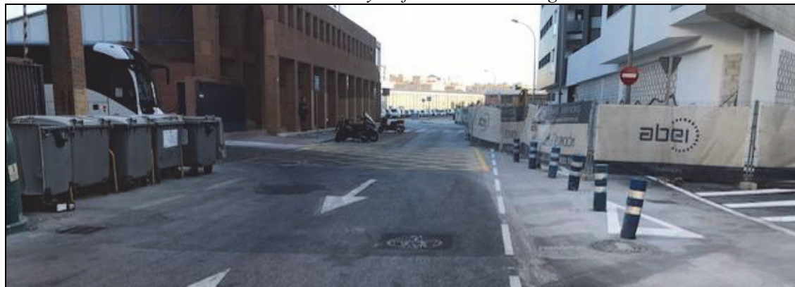
Ilustración 50: Actuales obras de urbanización y edificación en Calle Eguiluz.
