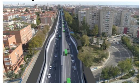
Soterramiento de la A-5. Paseo Verde del Suroeste. Madrid
