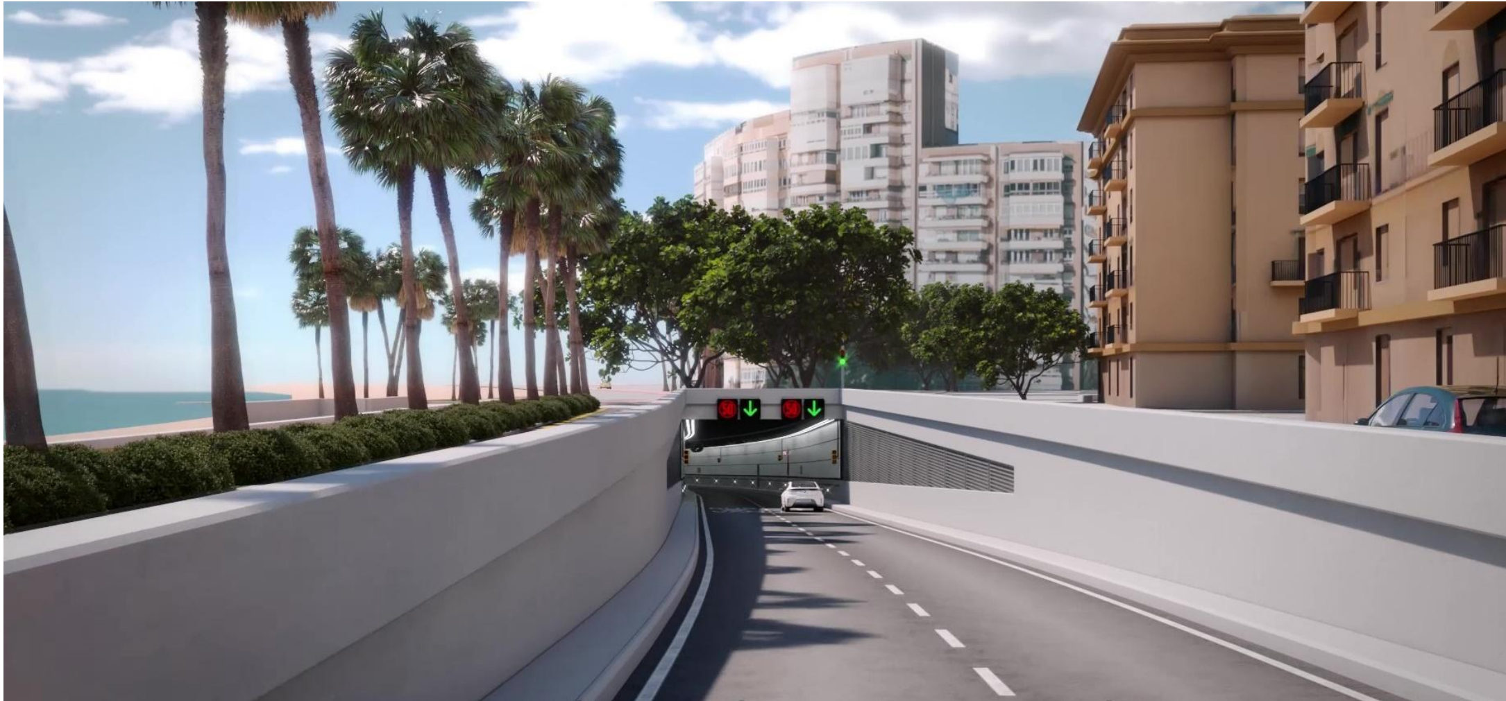
Vista de acceso al túnel desde la boca este
