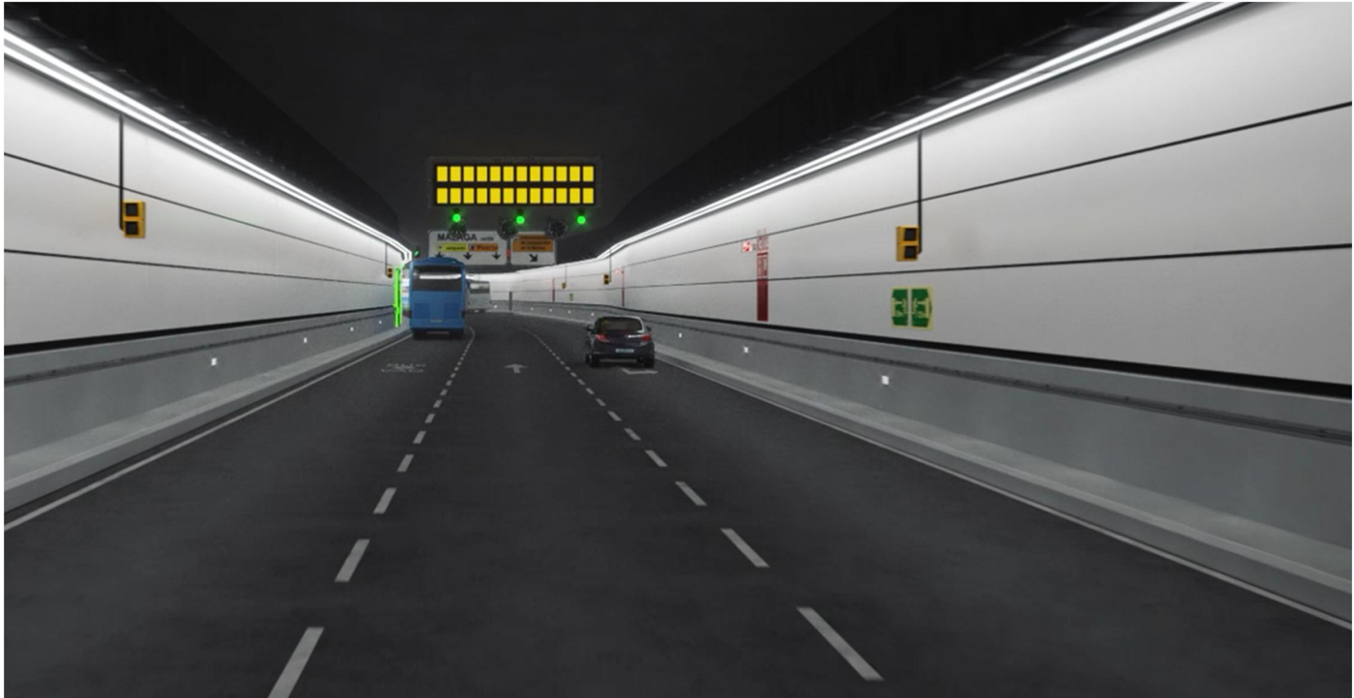
Vista del túnel bajo Paseo de los Curas.
