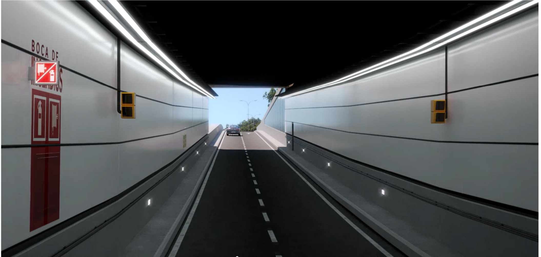
Vista de rampa de salida en la boca oeste
