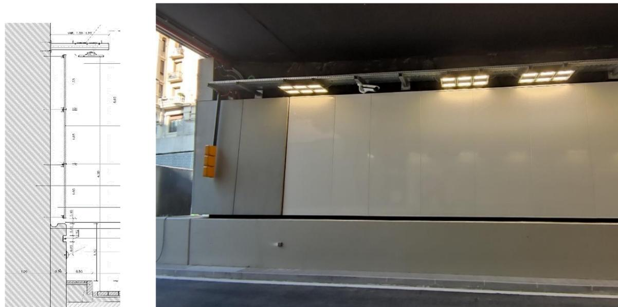
*Acabado del paramento vertical con el panel de acero vitrificado y murete de hormigón armado en la base*
